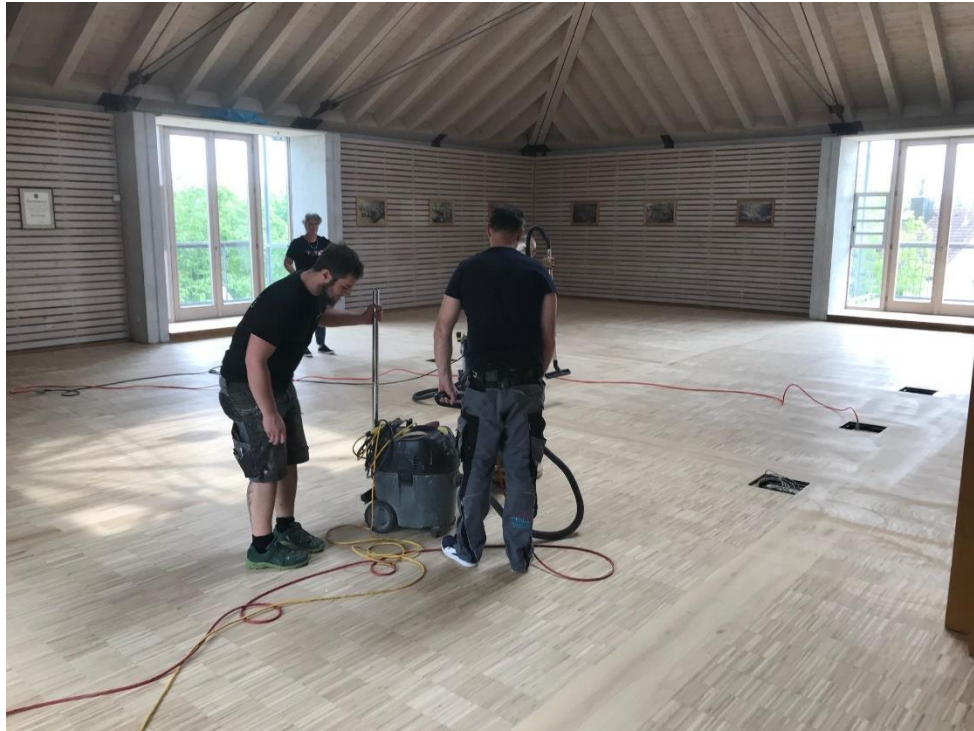
Renovierung Sitzungssaal, natürlich mit heimischen Firmen.
